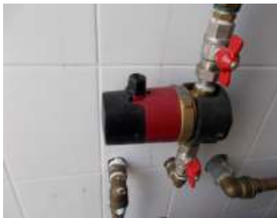
A bekötetlen cirkulációs szivattyú
