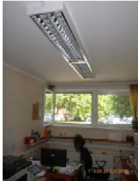
Beltéri világítás tükrös rácsos lámpatestekkel
