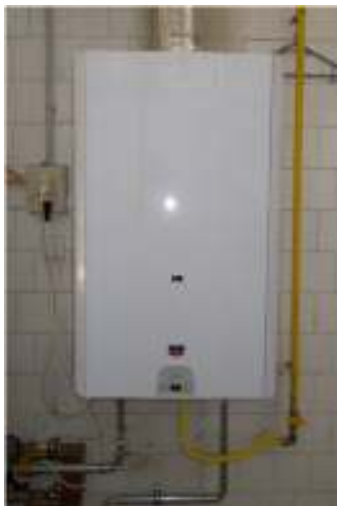
Atmoszférikus gázkazán a prospektúra épületében
