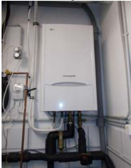
A hőszivattyú beltéri egysége
