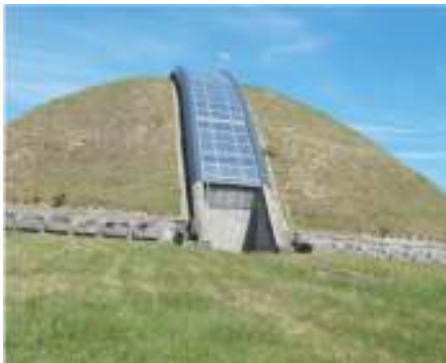
A profilüveg tetőszerkezet
